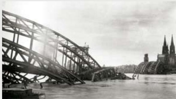
1945, über und im Rhein die gepresste Holztafelbrücke
